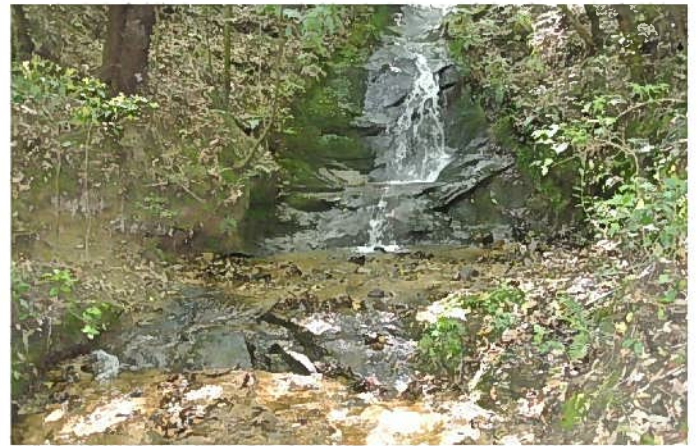
滝からの水と土砂で大きな土管が詰まり道に溢れる
