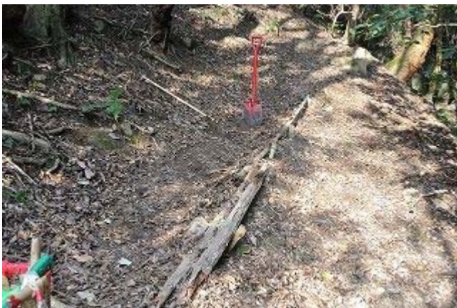
壊れていた路肩 古木と杭で補修
