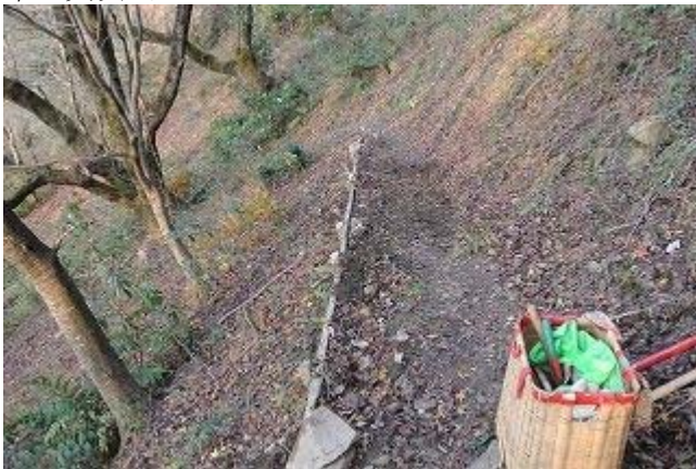
猪が壊した路肩を復元後
