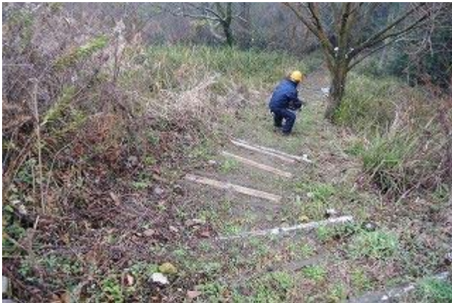
険しい100段の階段窪んだ所を廃材垂木を埋め込み 中 矢吹氏
