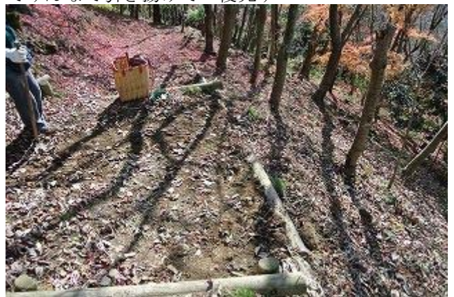
路肩がなくなり崩落の登山路 浮いていた丸太を抜いて移動させて登山路の整備に使用
