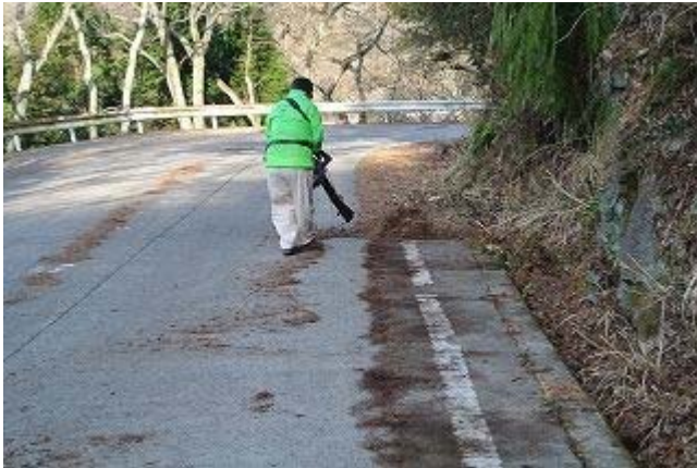
ブローアーを稼働させて登山道路の落ち葉を撤去中の 広兼
