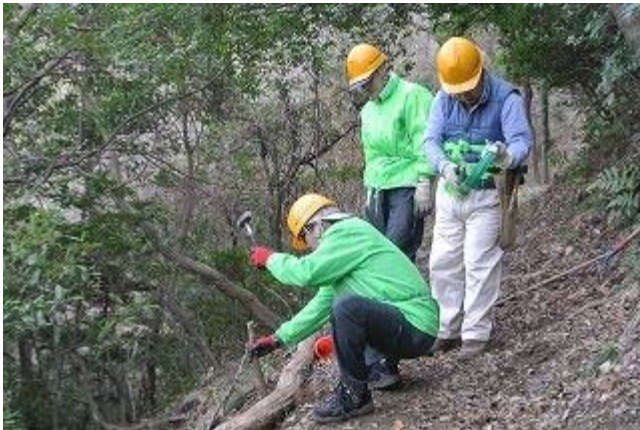
谷に転がっていた古木を引き上げて路肩補強中 手前 福馬
