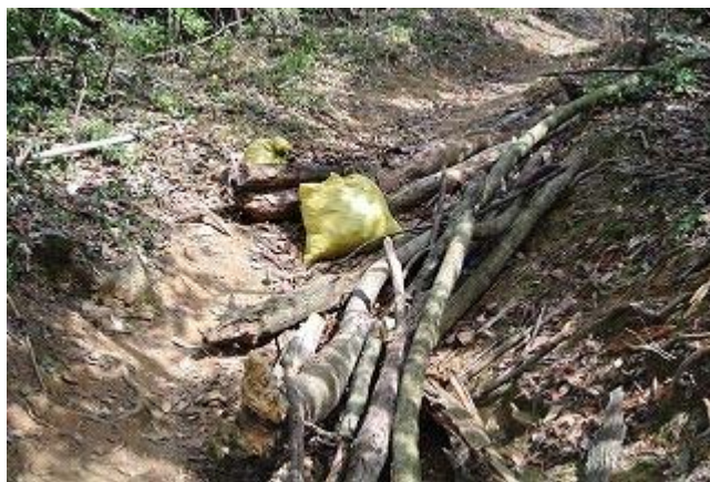
水の流れが鈍くなる様に古木・土嚢で抑制
