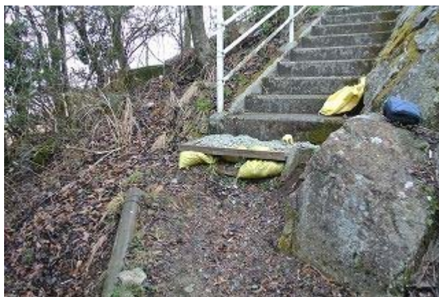
持参の木杵・土嚢袋・バラスで最下段を補強す
