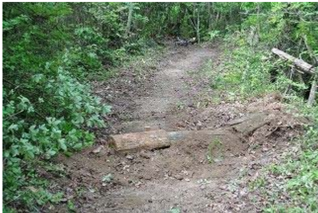
枯れた倒木を利用して横断溝を新設
