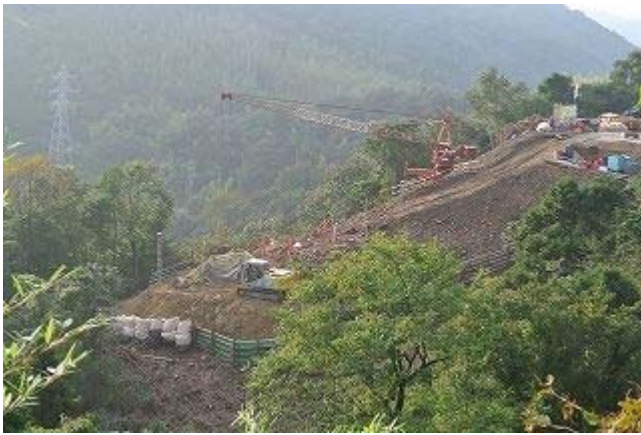
灰ヶ峰 送電線の鉄塔工事現場
