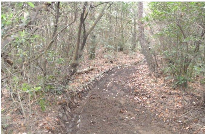
玉石のできていた側溝復元
