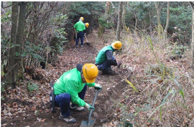
遊歩道 玉石の側溝を掘り下げ中
