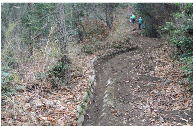
玉石のできていた側溝復元
