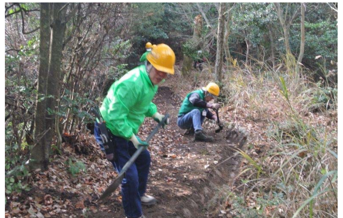
刃の有るスコップで側溝を復元中の成田氏 宇吹氏
