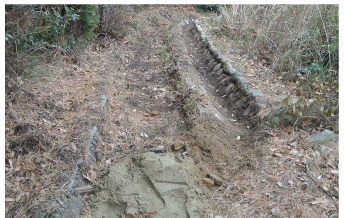
路に雨水か流れないように盛り土をして側溝へ誘導
