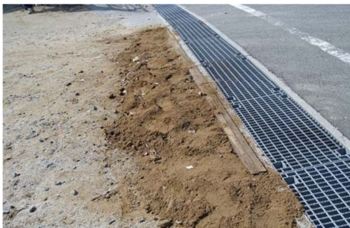
深山の滝入口前 駐車場の進入口に土砂を盛る 2/13
