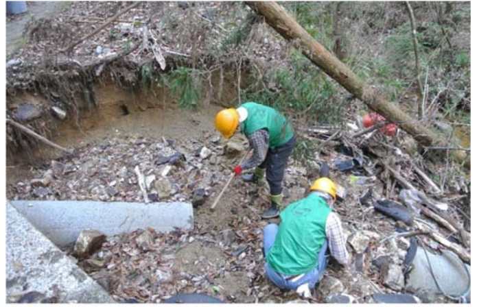
崖下の壺が詰まって大きな土管も流す。水路作り中
