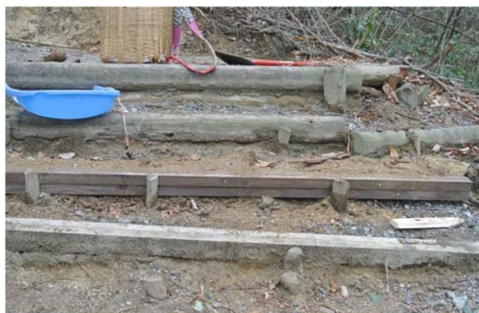
大庭山 階段廃材垂木4本をネジギで1組で 取り替えた
