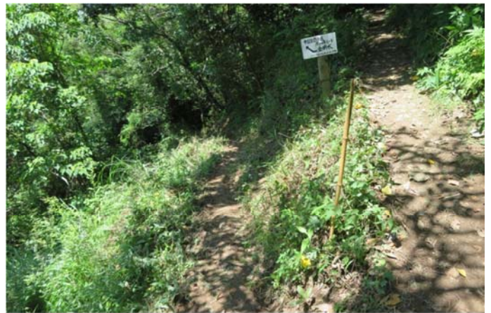
整備後の進入路 幅員を確保
