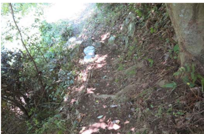
路肩に廃材垂木 番線で固定 土嚢を滑り止めに使用
