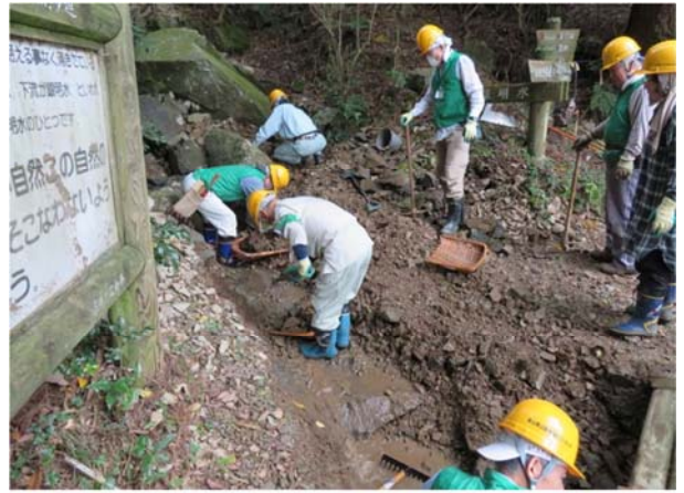
水が地下に潜らないように掘り込み中
