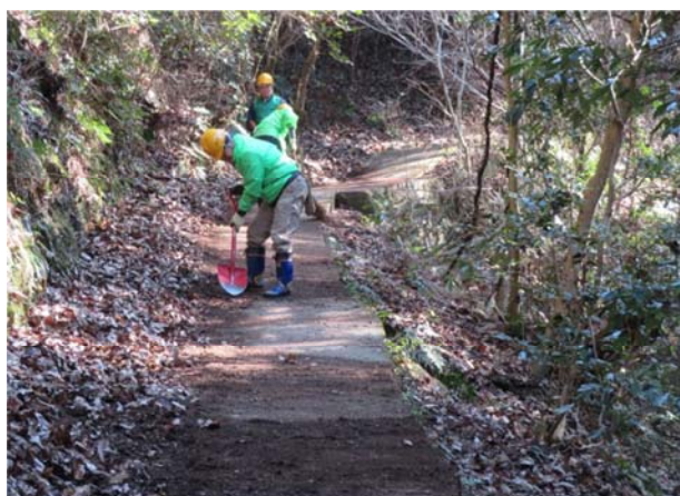
自然歩道 こびり付いた土砂・落ち葉を撤去中
