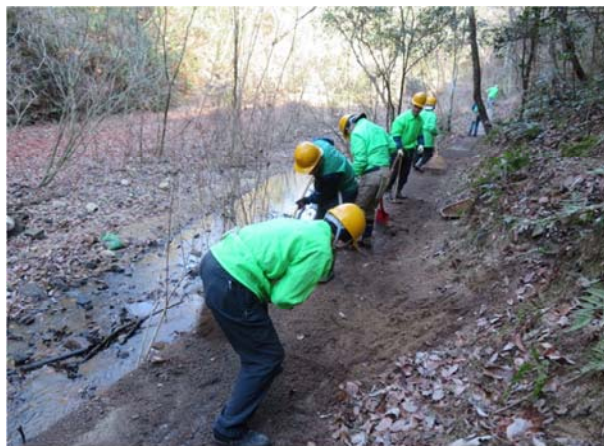
自然歩道 コンクリートにこびりついた土砂を撤去中
