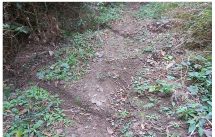
登山路に溝を掘って、水を横に流す（路を保護）
