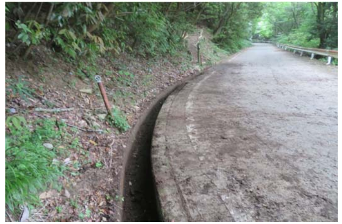
側溝の石・土砂を撤去後 大変な重労働で遂行
