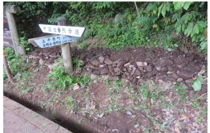
側溝から掘り出した石を使って石垣を作った
