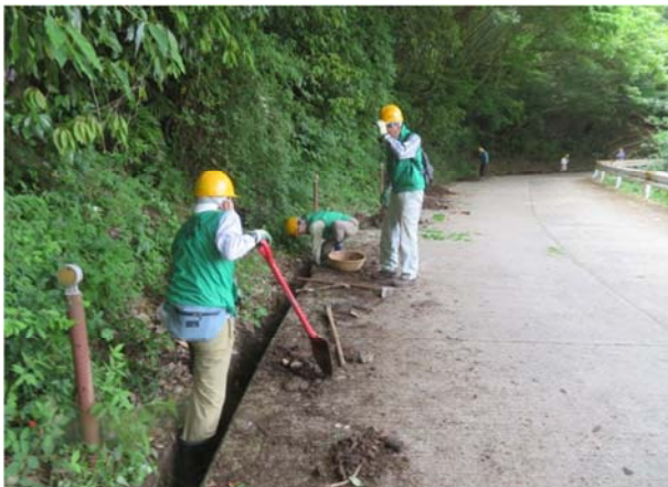
側溝に足を入れて 石・土砂を掘り出す
