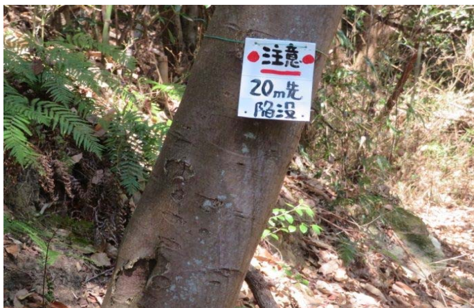
崩落した自然歩道 復旧のため窪地も埋めた
