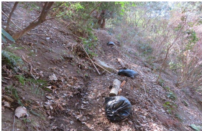
登山路が細く危険のため 土嚢 鉄杭で手入れ
