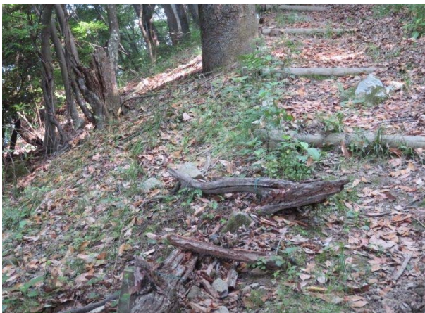
古木で路肩を固めていたが荒らされていた
