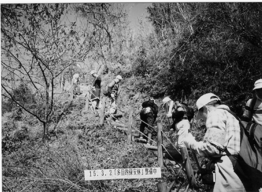
バス停近くの進入口、勾配が高い階段整備中
