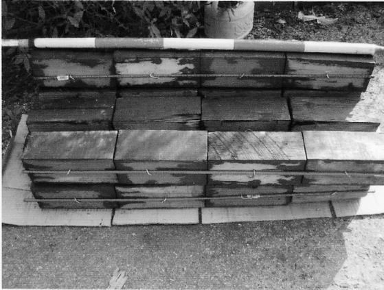
階段用に組んだ角材 ((10×10×25cm)4個を10mm鉄筋で固縛)
