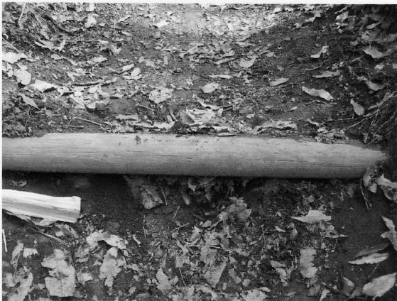
丸太の周りを水が流れてむき出しになる寸前の階段
