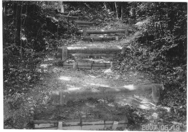
階段の窪地へ土砂を入れ込み歩きやすくなる
