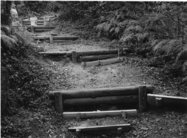
今回階段を増設して土砂を入れる前
