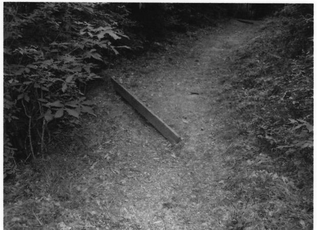
廃材の板を活用して横断溝を新設
