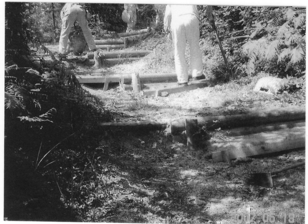
今回増設した階段へ土砂を埋め込み中
