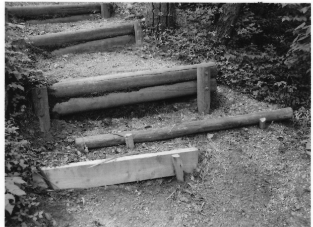
丸太と杭で階段を増設後
