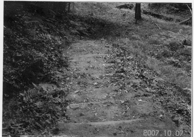
草刈後と整備した階段
