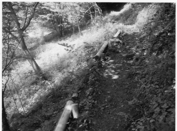
丸太をボルトで締め付けた杭をカケヤで打込む
