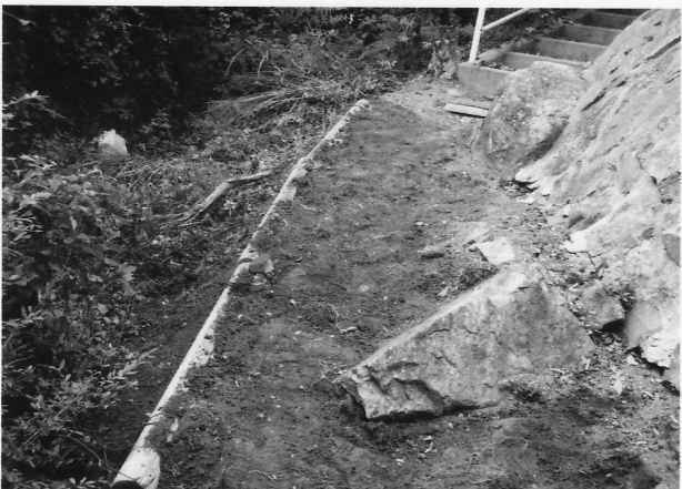
頂上展望台真下の弱い路肩に廃材丸太3本を取付ける (径12cm×長さ1.5m)
