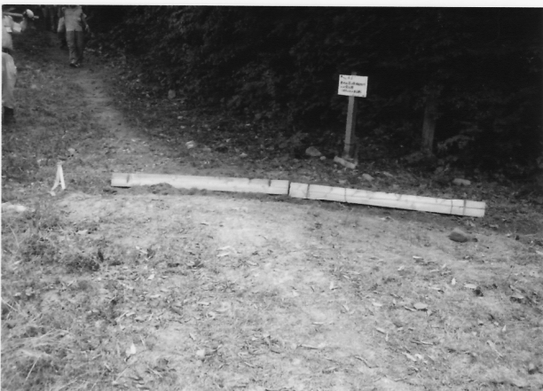
廃材丸太を半分にして、2本並べて横断溝を作る (径12cm×長さ1.5m)
