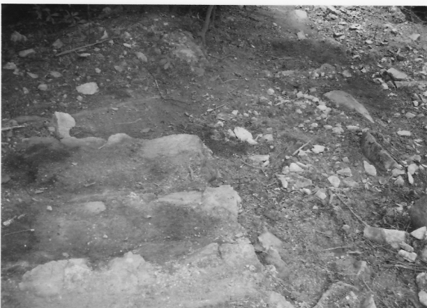
階段の土砂を撤去、清掃後
