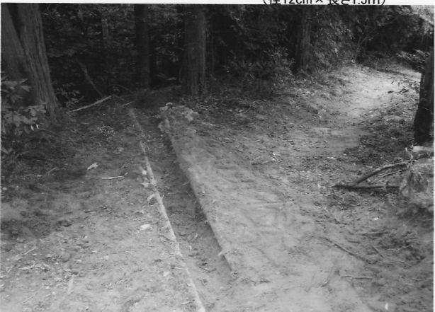
林の中の倒木を杭で固定して横断溝を作る
