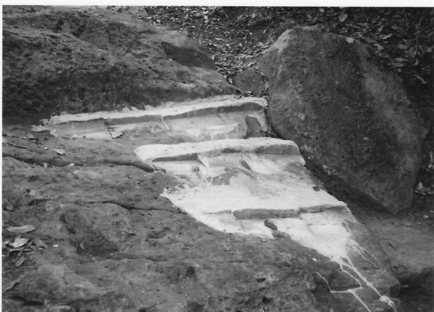
岩場の登山路に滑り止めセメントの階段を作る
