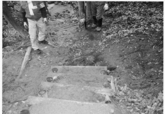
土砂を入れて土止めを作る
