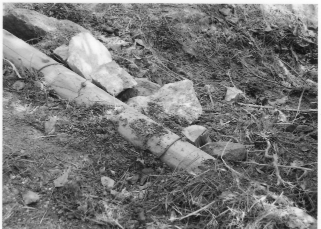
丸太(8cm×100)、番線、杭で水路設置
