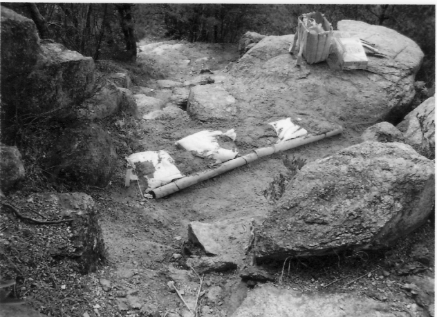
頂上手前にも水路敷設
