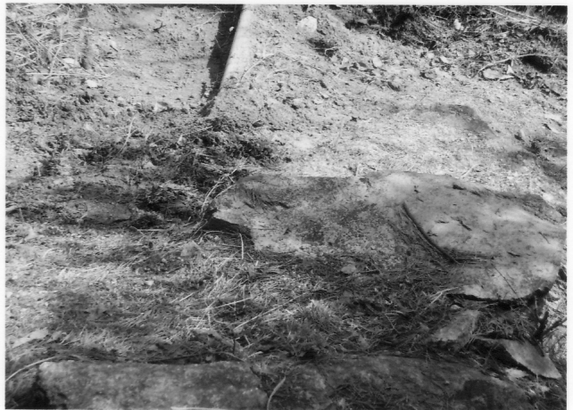
丸太と番線および杭で水路新設
