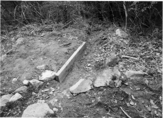
(15cm×5×100)の板に穴を開けて番線で固定、水路をつくる
