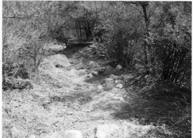
水路を掘り込む
