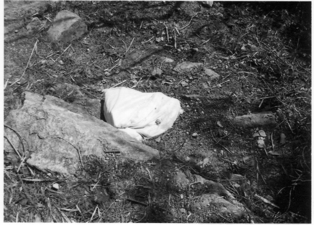
小石を袋に詰めて崩落防止
