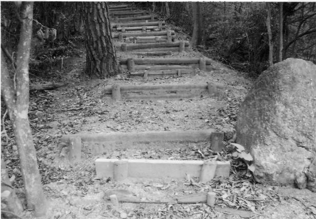
階段に使った廃材の丸太が腐りかかっている
