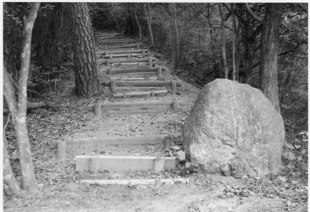
腐りかかった丸太を取り除き新しい丸太と交換後
