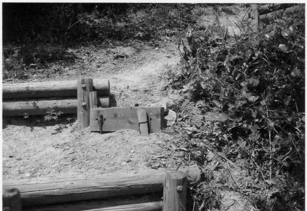
(5×15×50cm)の板に穴を開け番線で杭に固定して階段増設
