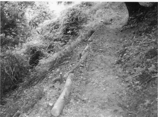
杭で固定した丸太を並べて路肩を補強する
