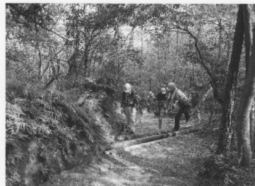
増設階段へ土を搬入
