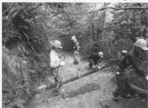
大庭山にて作業中
