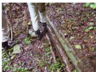
足元や深い箇所溝に板を挿入して取り付ける
