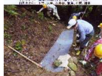
土が深く傾斜溝に挿入した記一ルは板を設置
