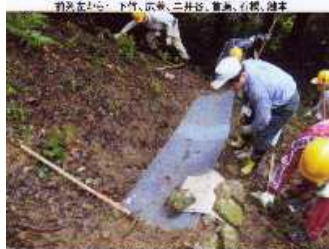
土が深く傾斜溝に挿入した記一ルは板を設置
