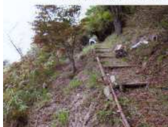
土が深く傾斜溝に挿入した記一ルは板を設置
