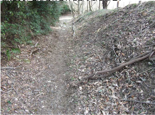
土砂崩れ防止用枝木設置前
