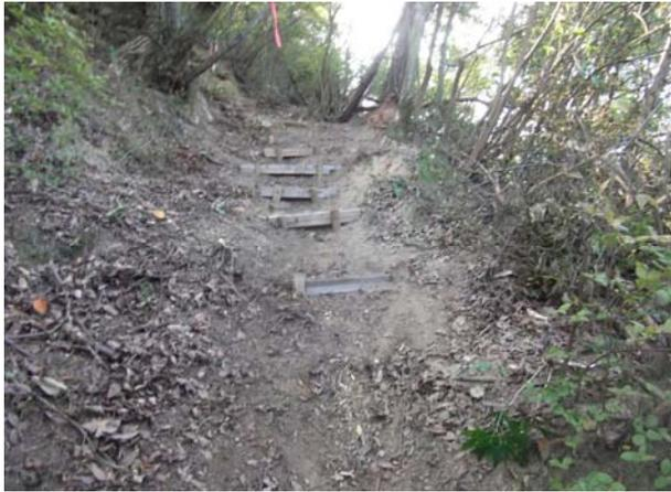
滑りやすい斜面に階段6段を新設
