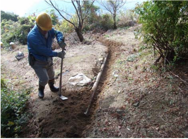
八合目、水路を丸太で補強、丸太は番線で杭に固縛
