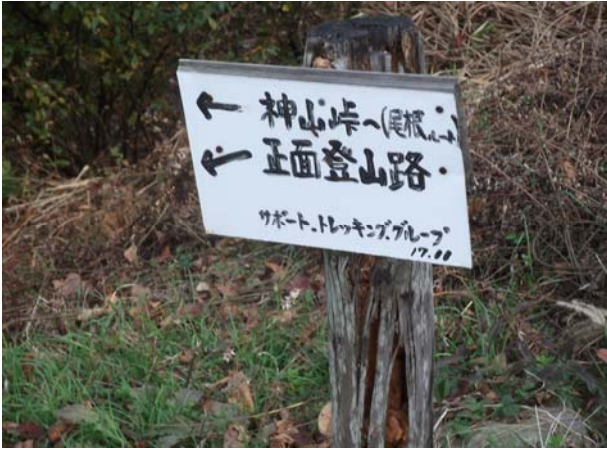
七年前に設置した道標の支柱が腐っている
