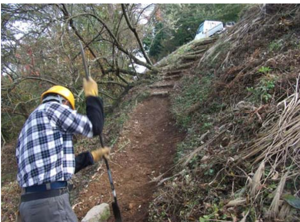
九合目、狭くなった路の拡幅作業中
