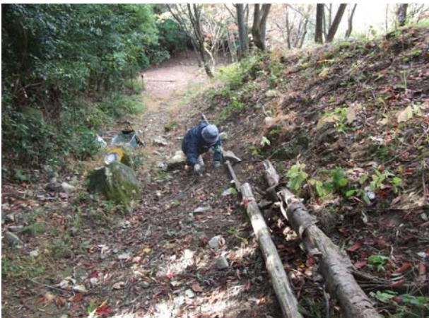
土砂止めを取り付け中
