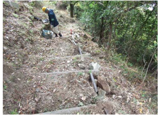
廃材を活用して路肩に崩落防止材を取り付け中
