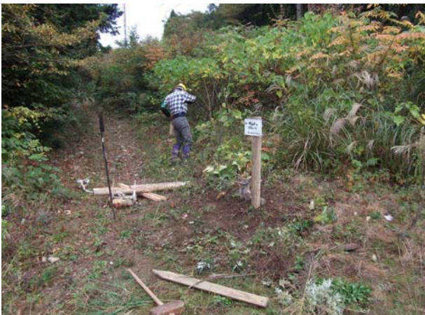
七年前に当会が設置した道標の支柱が腐っている
