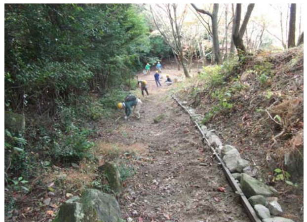
土砂崩落の防止処置を行った後
