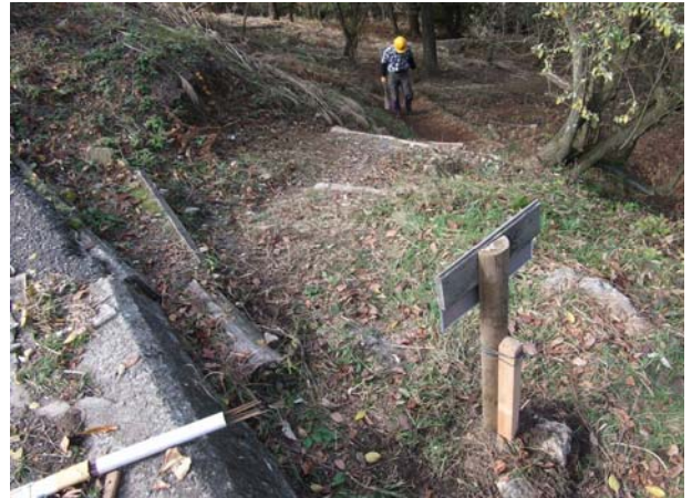
支柱取替え後
