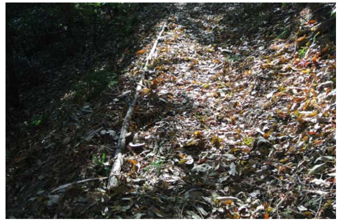
丸太で補強した路肩
