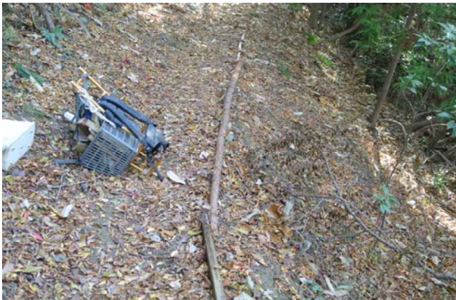
丸太、廃材垂木を使って路肩補強中
