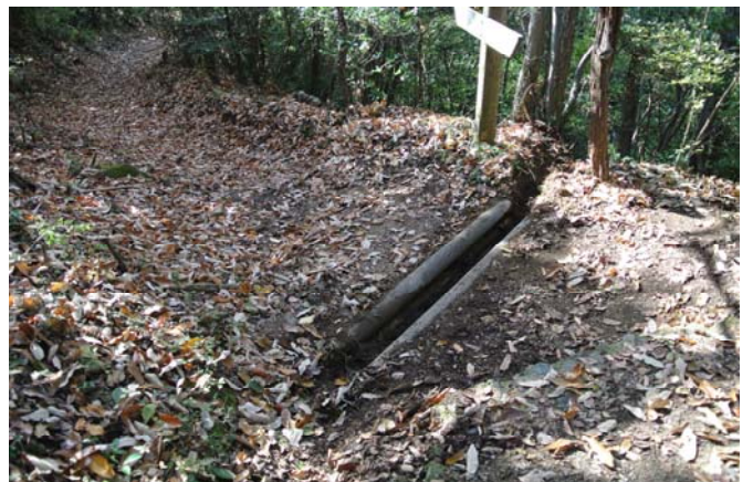
落葉・土砂を撤去後の横断溝(整備・清掃後)
