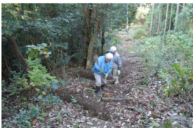
尾根ルートの階段補修中
