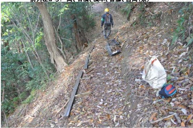
廃材垂木で路肩補強中
