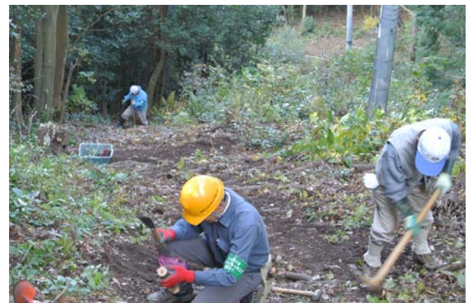
階段を補修中
