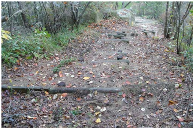
補修前の「上山」の手前
