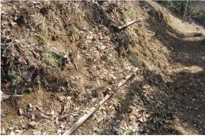
地面の崩落止めに廃材垂木を使って補強
