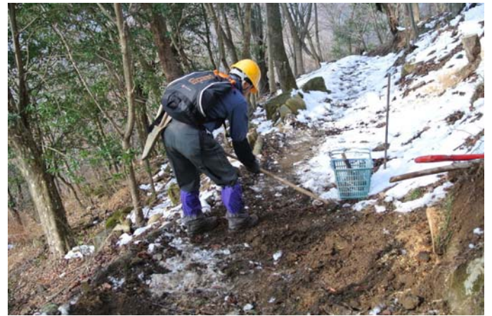
倒木切断・片付け後
