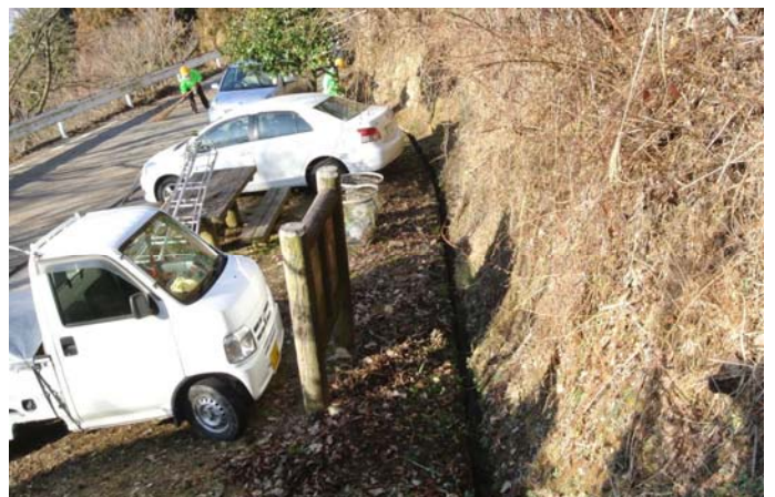
掘起し、清掃後の側溝
