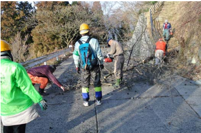
倒木伐採後の片付け、清掃作業
