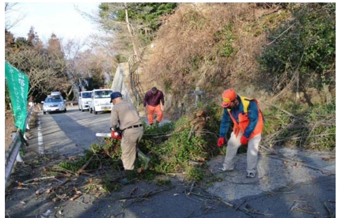
倒木伐採後の片付け、清掃作業
