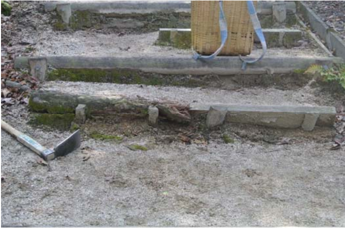
枯れ木を使って階段補強
