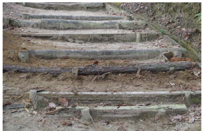
腐蝕した丸太を枯れ木の丸太に交換後
