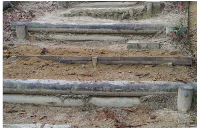
廃材垂木4本と交換補修後
