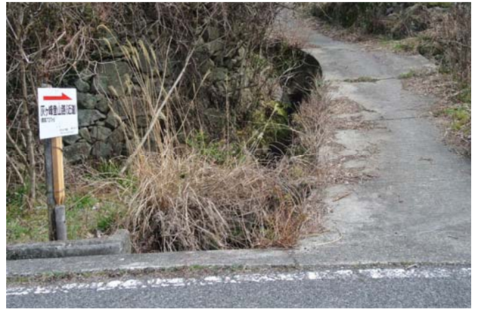
新標識を支柱に取り付け
