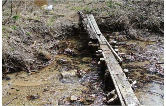
落葉、流木を除去。橋を延長補強後
