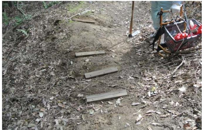
廃材2本を釘で止めすべり止めとして設置
