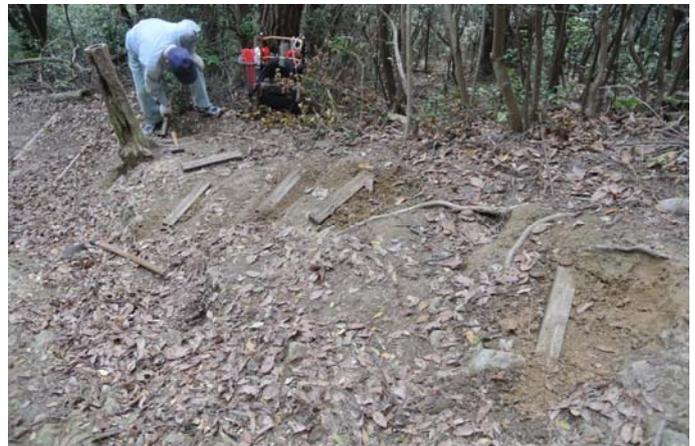
滑り止め材として使う垂木2本を25cmの釘を打ち付けて組み合わせているところ
