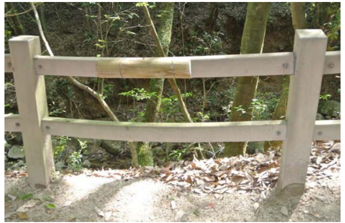
折れた部材を補修後
