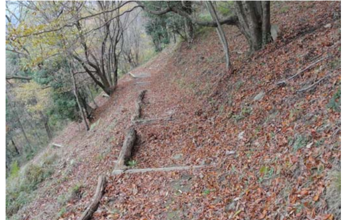
倒木で路肩補強
