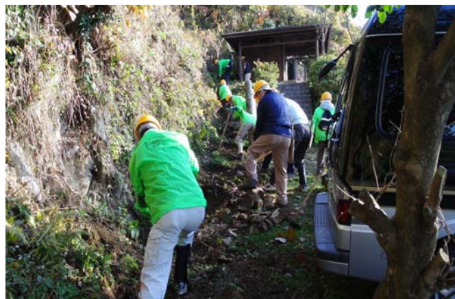
側溝掘り起し中
