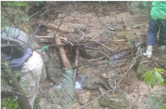
流れを堰き止めている流木を撤去中
