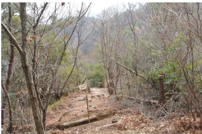
枯れ木を除去、横断溝を掘り起こす
