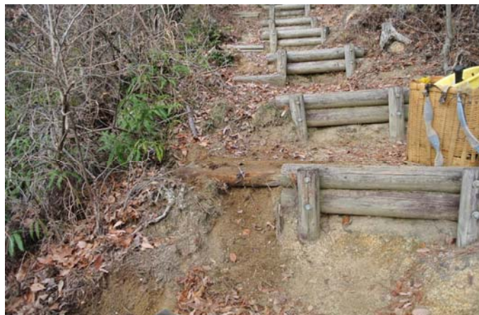
焼け残った丸太を活用して階段を補修
