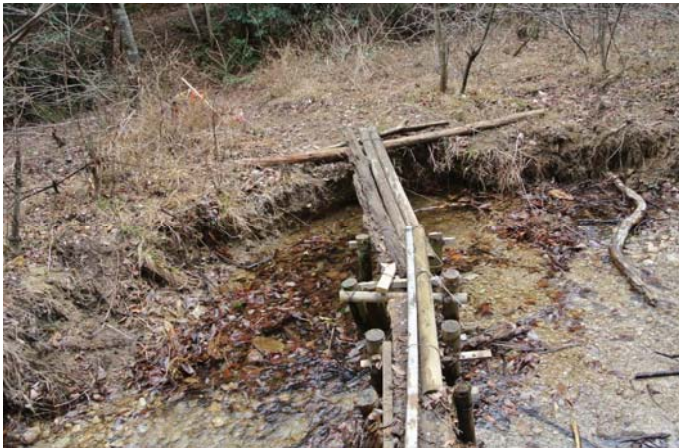
現場に転がっている枯れ木と、持参の材木を使って橋を補修
