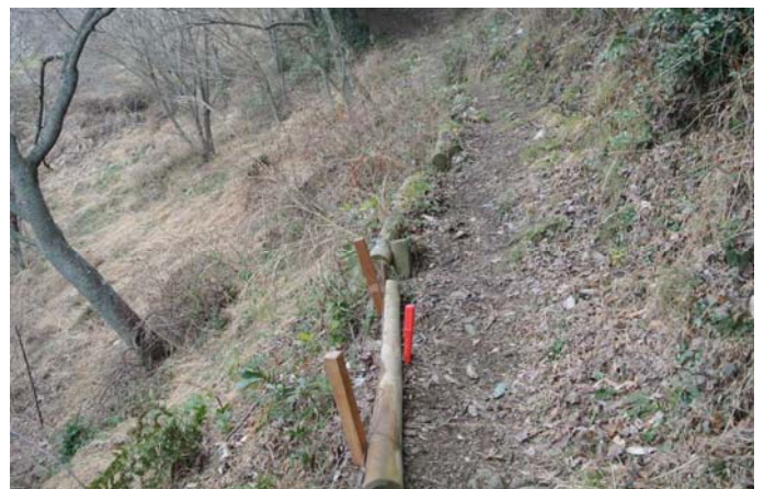
路肩補強作業中
