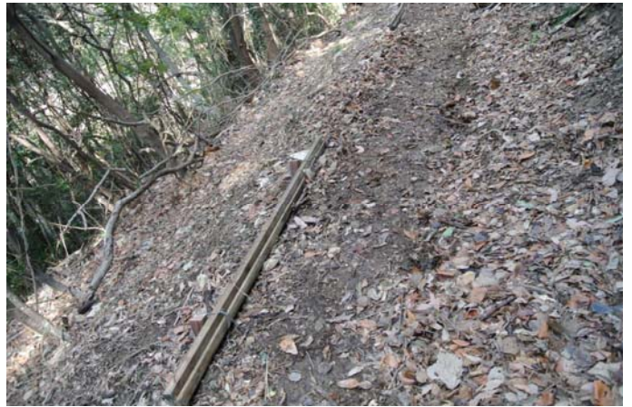
廃材垂木で路肩を補強
