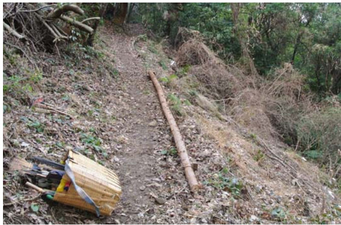
路肩を丸太で補強後
