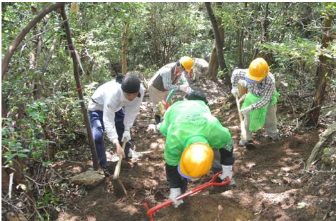
急傾斜の階段を整備中
