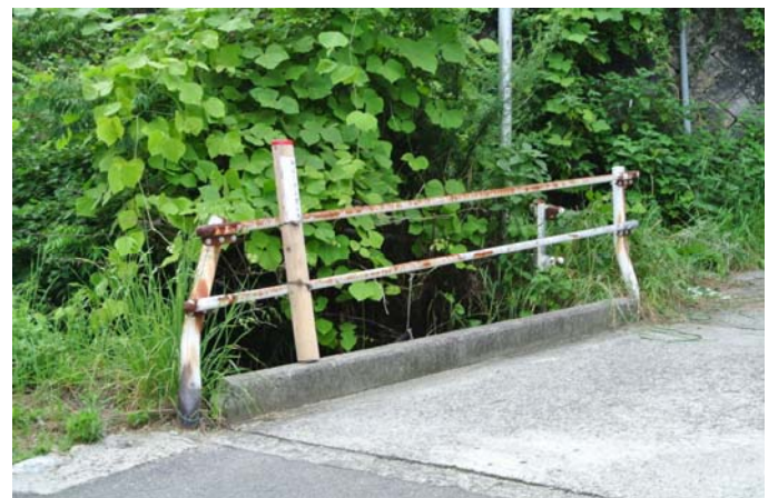
登山道路の進入口である橋の上に道標設置
