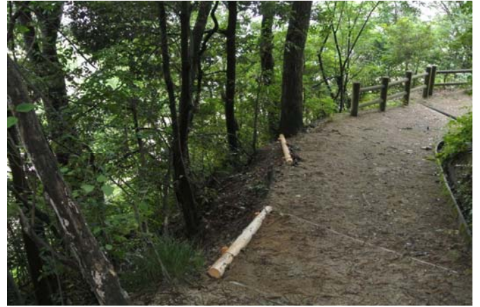
路肩補強に丸太を取り付けた
