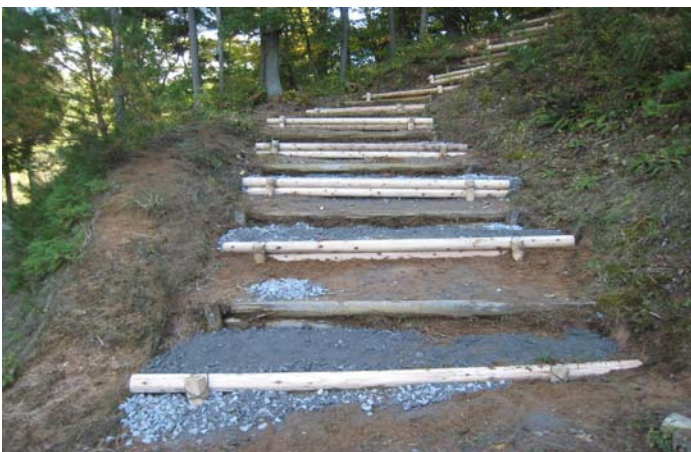
支給材(丸太、丸太の杭、パラス)で完成
