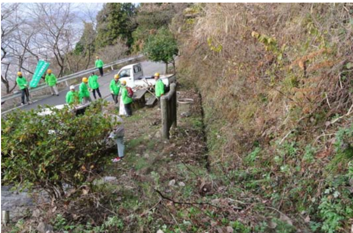
掘り返し清掃後の側溝
