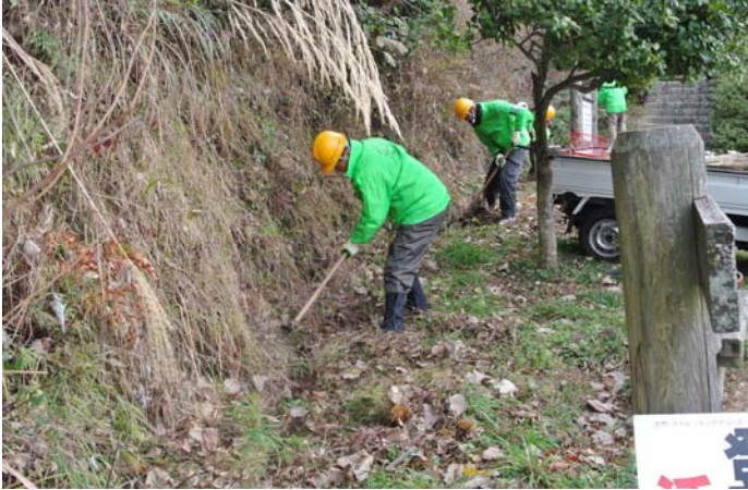
路傍休憩所隣の側溝を掘り返し清掃中
