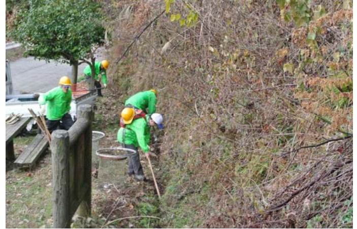
側溝を埋めた土砂、落ち葉を撤去中
