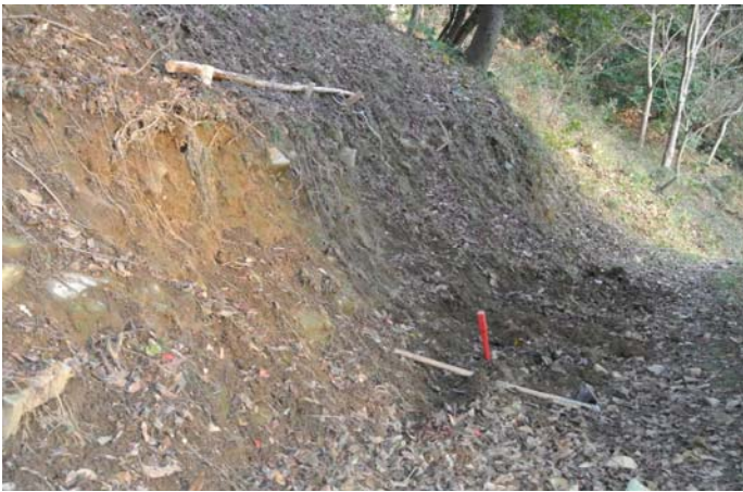
山側の崩落現場
