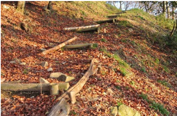
路肩に土砂防止用丸太を据付前
