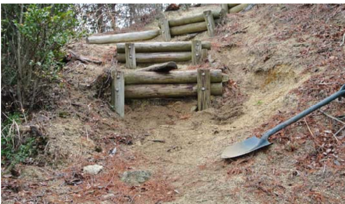
階段の用を成さなくなった丸太を活用して蹴上がり を少なくして段差を減少させた
