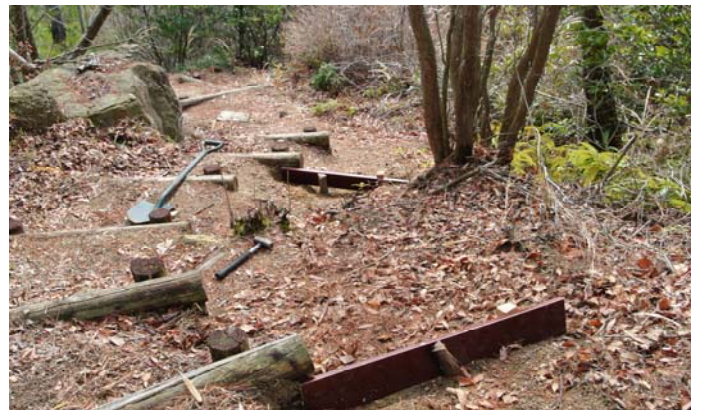
灰ヶ峰に捨てられていたベットの枠を階段の補修に廃材活用
