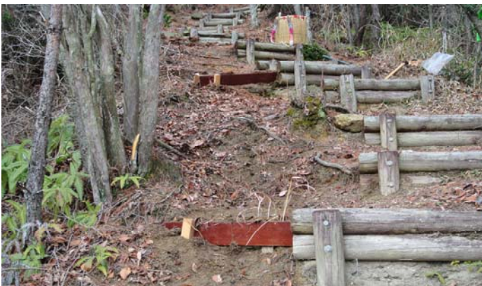
ベットの枠を階段の補修に有効活用
