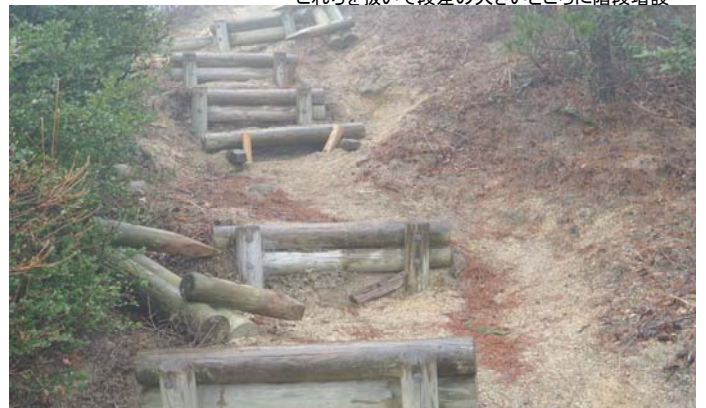
用を成さなくなった階段の丸太をそのまま利用して段差を小さくした
