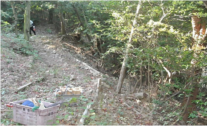
路肩を補強中
