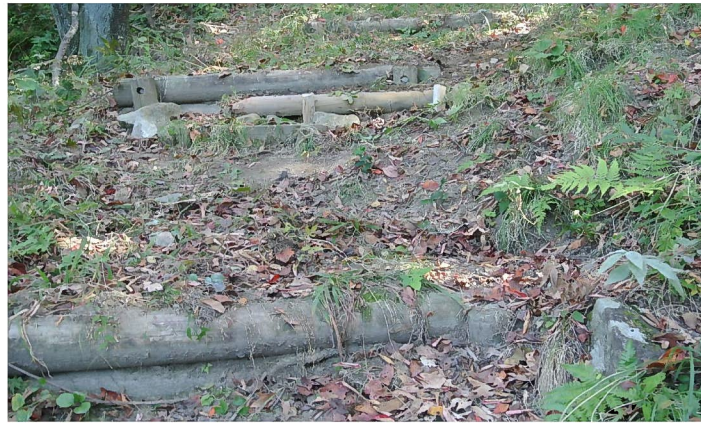
半丸太で階段増設後
