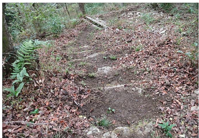
石段の土砂を除去後
