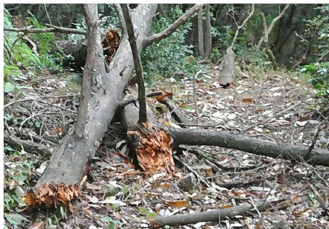
整備前の路がふさがれた状態
