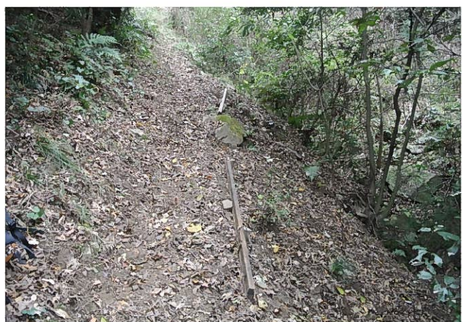
路肩補強の一手段として土砂の流出を減らすために廃材垂木を設置
