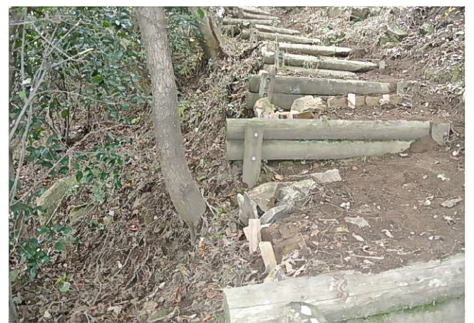
くぼんだ階段を杭と石で補修
