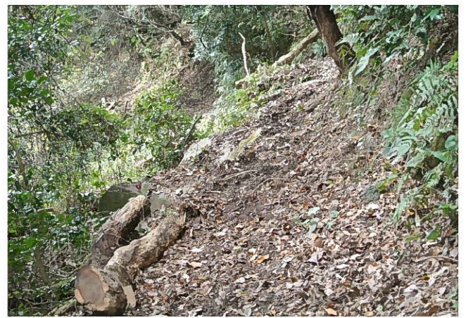
切断した倒木を路肩補強に活用
