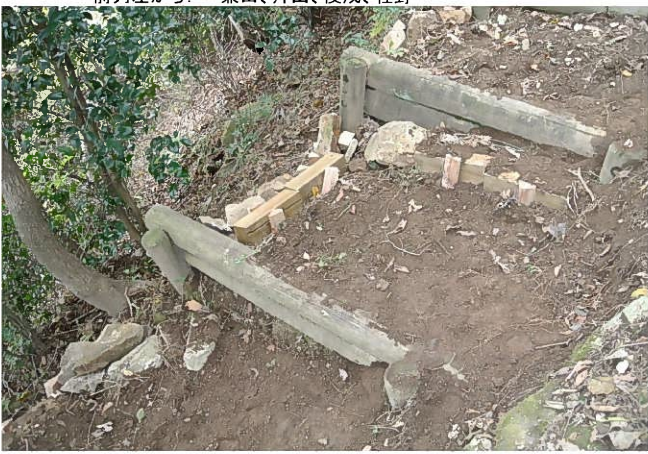
くぼんだ階段を杭と石で補修
