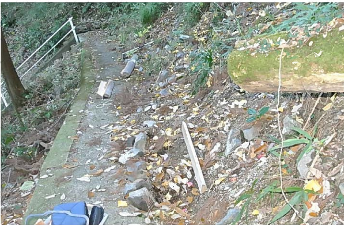
手入れ前の参道
