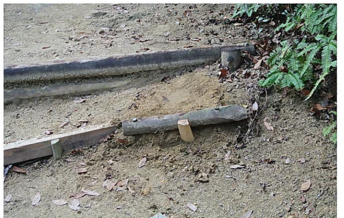
補修した階段
