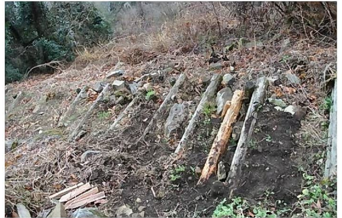
廃材を活用して階段の増設 蹴上げを小さくする
