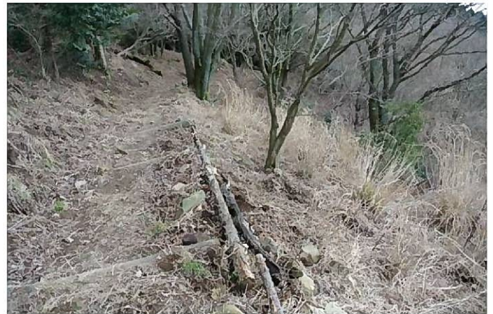
廃材を活用して路肩補強
