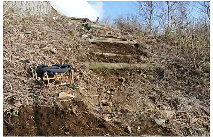
猪が壊した階段などの補修増設
