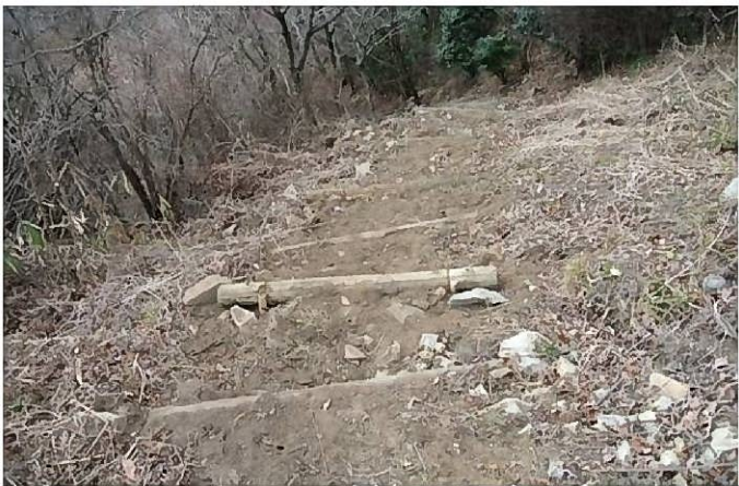
20数本の廃材丸太を使って階段増設
