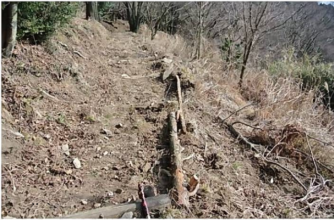
廃材を使って路肩を補強中
