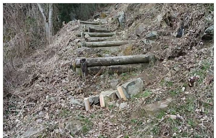
石と杭で階段増設
