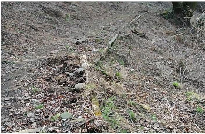
手入れ前の路肩
