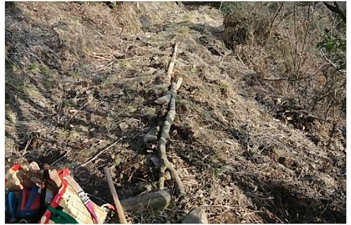
灌木を活用して路肩補強
