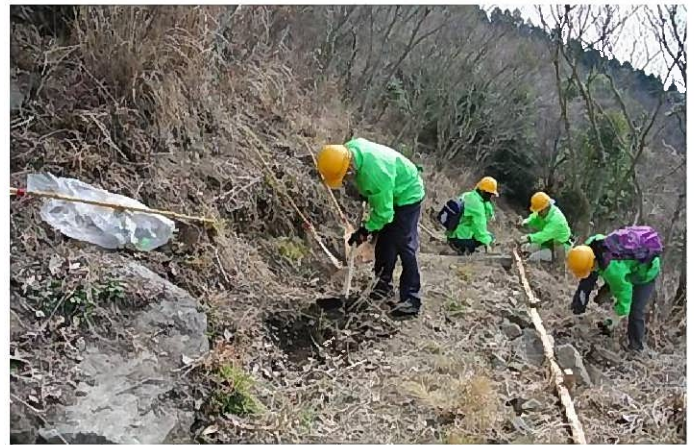
猪が崩した路を補修中
