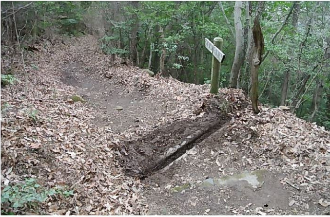
ハンドブローアで落ち葉の撤去・横断溝の掘り下げ
