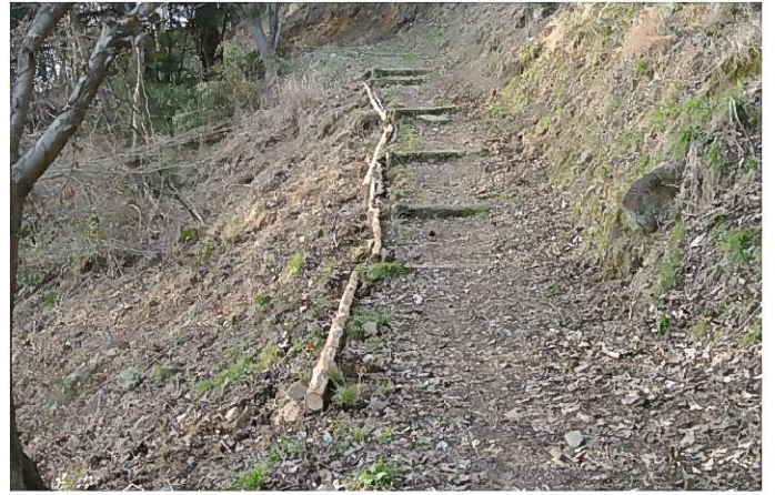
廃材丸太を活用して路肩補強
