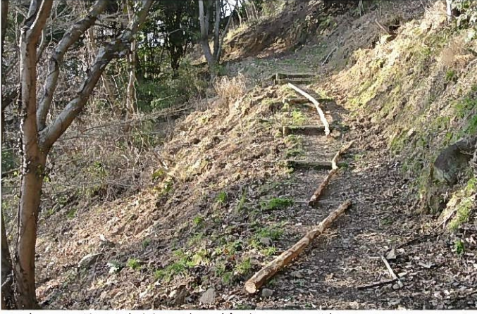
森の間伐の廃材を路肩補強に活用前
