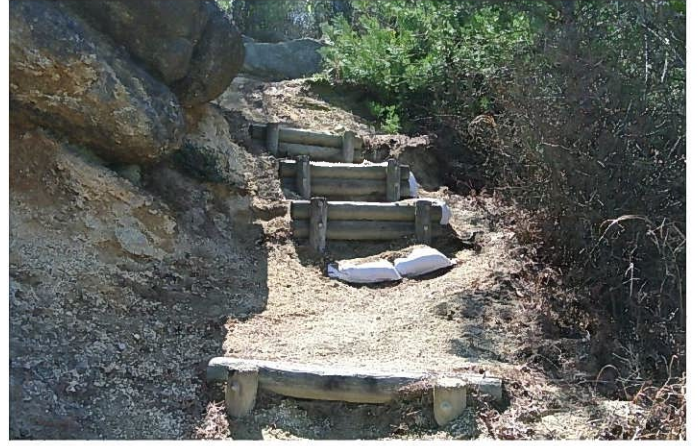
土嚢を使用してきつい階段の補修 烏帽子岩山コース
