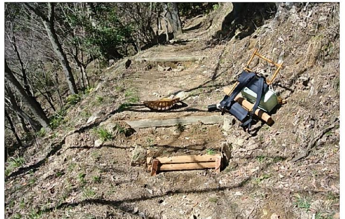
廃材丸太2本で階段の増設
