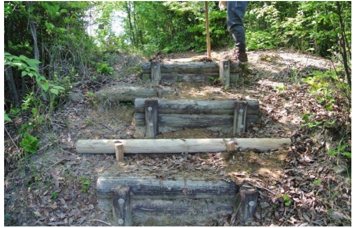
直径 10cm 長さ 1.5m の半丸太を担ぎ上げて階段増設
