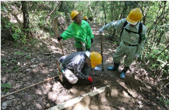
増設した階段を番線で杭と横木を固定中
