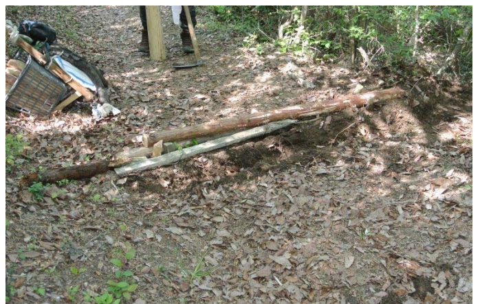
烏帽子岩山山頂北 80m 資材を担ぎ上げて横断溝復元
