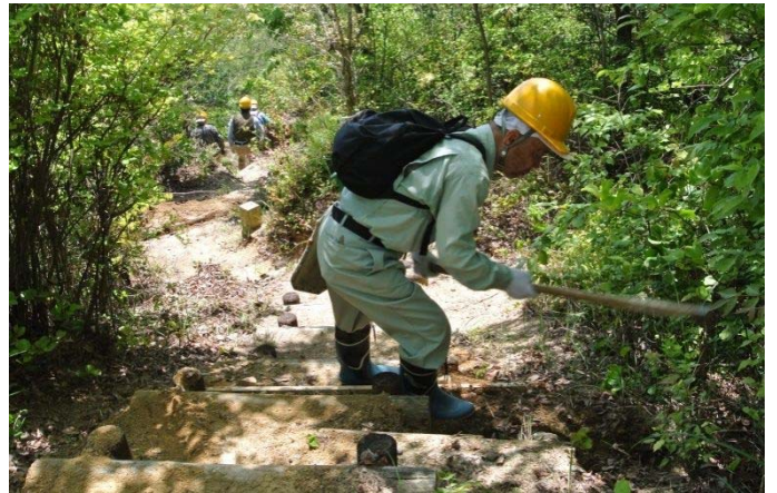
増設した階段に土砂を搬入している檀上氏
