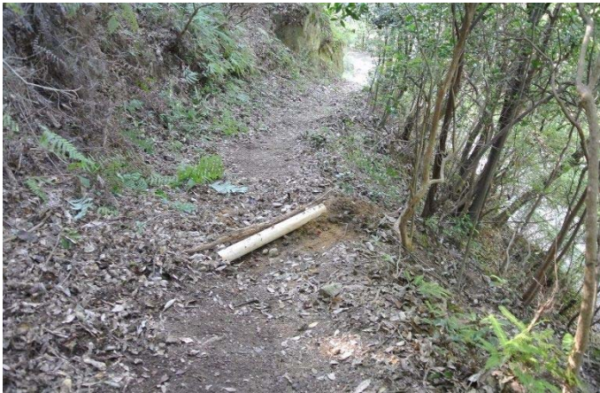
持参した半丸太・杭を使って水路づくり
