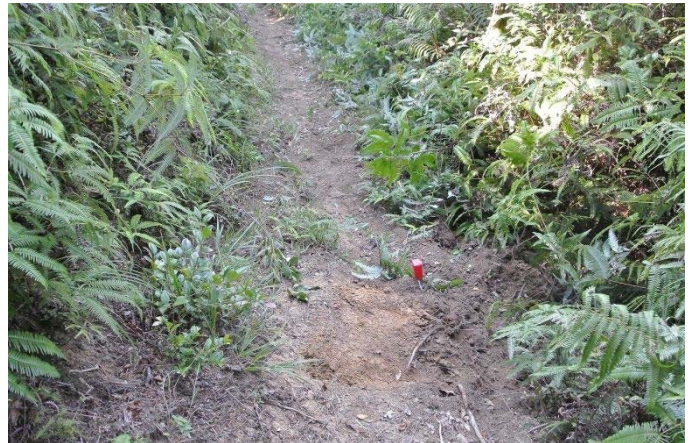
登山路を縦に流れる水を横に流す水路を掘る
