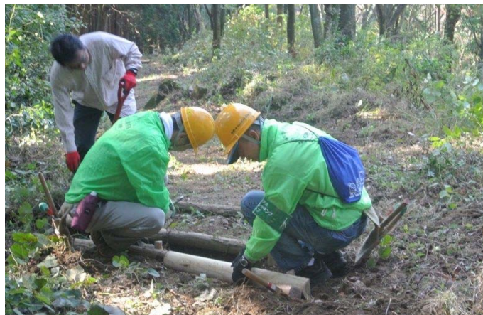
古くなり腐食が激しい横断溝持参の資材で取り替え中
